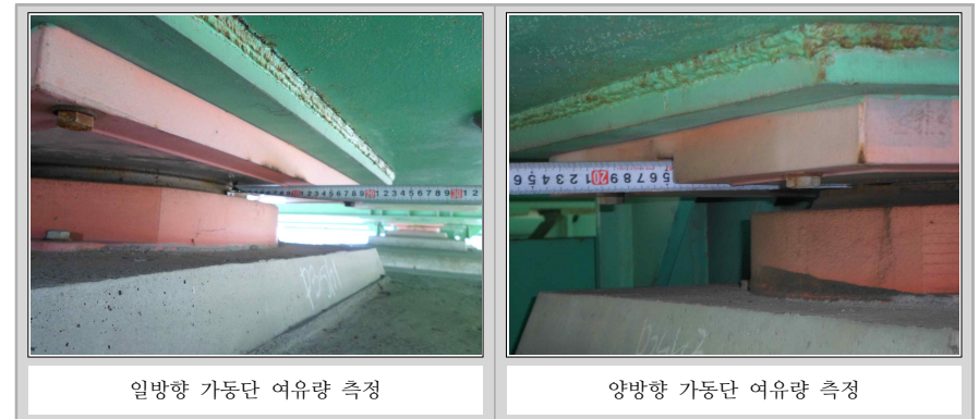
〈그림 2.1.9〉 받침장치 여유량 측정
