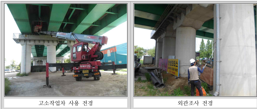
〈그림 2.1.1〉 외관조사 현황
