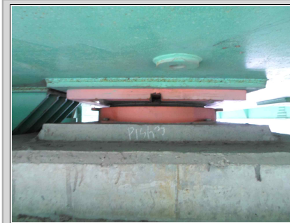
P1/Sh3 받침 상태양호
