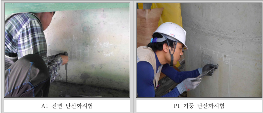
〈그림 2.2.2〉 탄산화시험 현황
